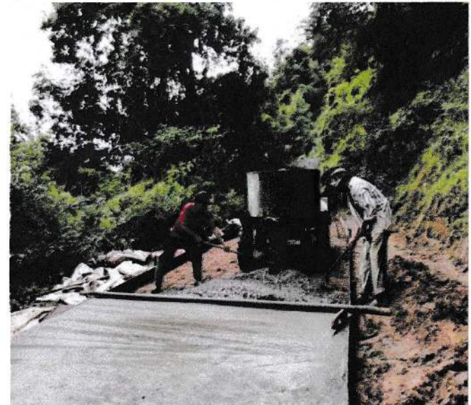
๑๙. ๑.ก่อสร้างถนนคอนกรีตเสริมเหล็ก หมู่ ๑
