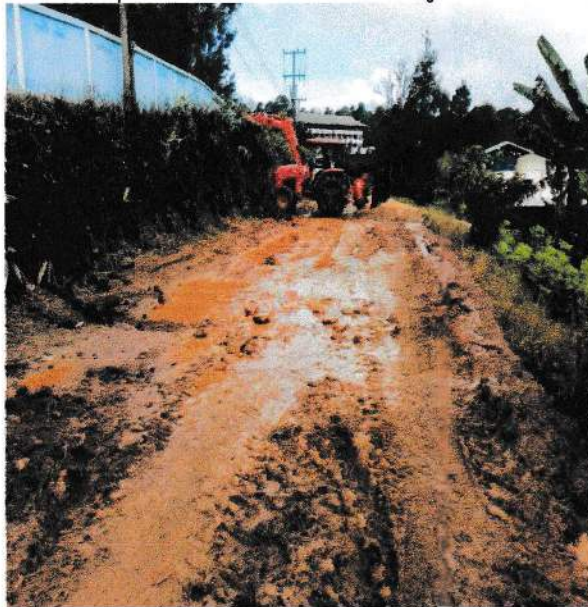
๑๐. ซ่อมแซมถนนลูกรังพร้อมลงลูกรังเป็นจุดๆ หมู่ ๓
