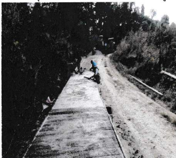
๗. ปรับปรุงซ่อมแซมถนนคอนกรีตเสริมเหล็ก หมู่ ๑๐
