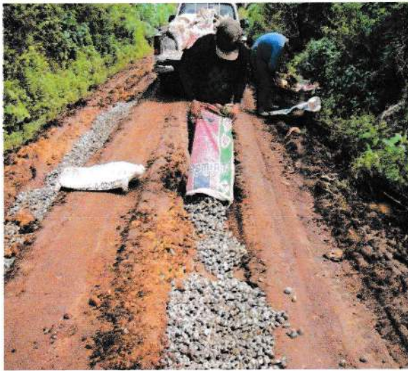
๑๕. ซ่อมแซมถนนลูกรังพร้อมลงลูกรังเป็นจุดๆ หมู่ ๙
