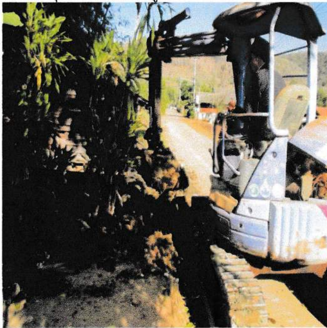
๑. ปรับปรุงรางระบายน้ำ หมู่ ๕
