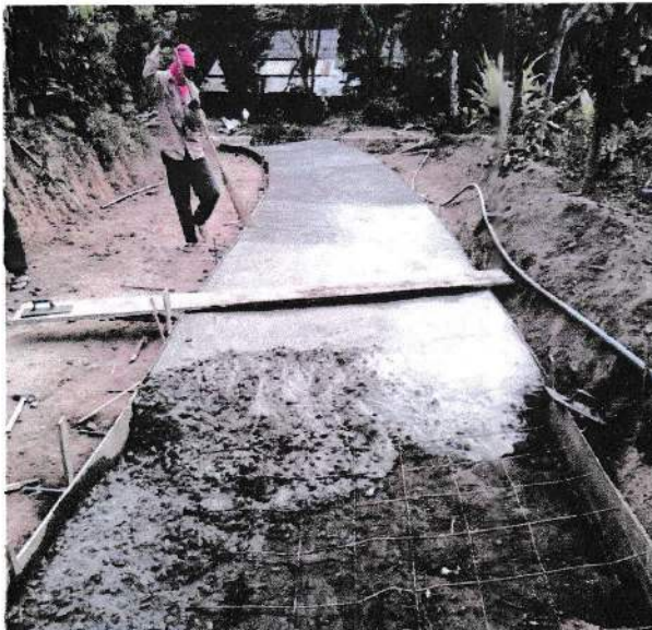
๗. ปรับปรุงซ่อมแซมถนนคอนกรีตเสริมเหล็ก หมู่ ๑๐
