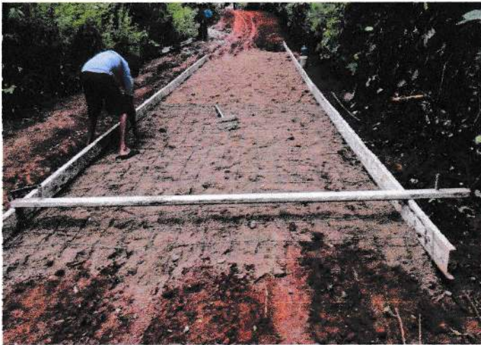
๑๒. ซ่อมแซมถนนลูกรังพร้อมลงลูกรังเป็นจุดๆ หมู่ ๑๐
