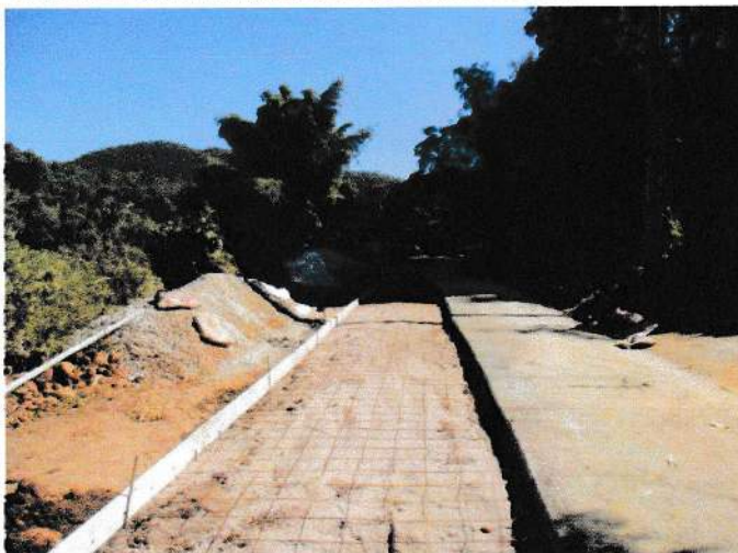
๑๖. ๑๐.ก่อสร้างถนนคอนกรีตเสริมเหล็ก ม.๑๐
