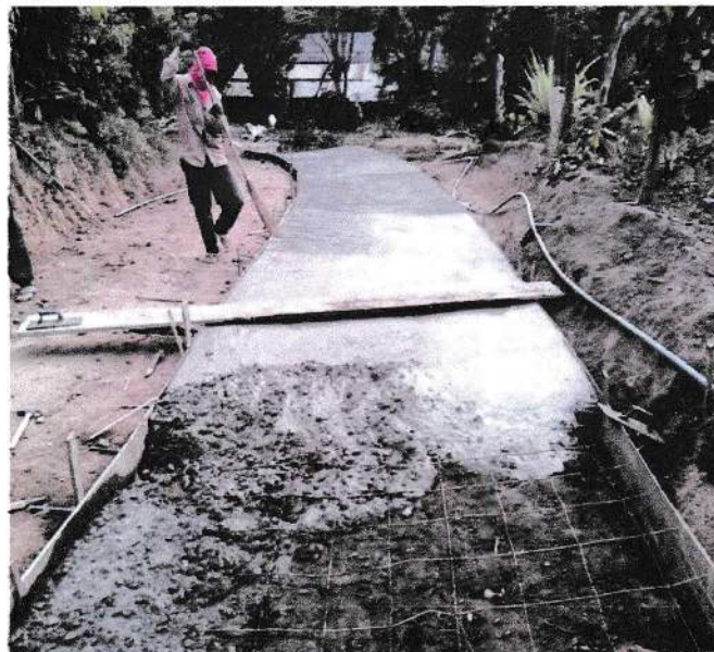
๒๘.ก่อสร้างถนนคอนกรีตเสริมเหล็ก ม.๘
